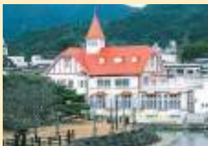
公衆浴場シーボルトの湯
