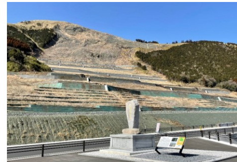
大規模斜面崩落
