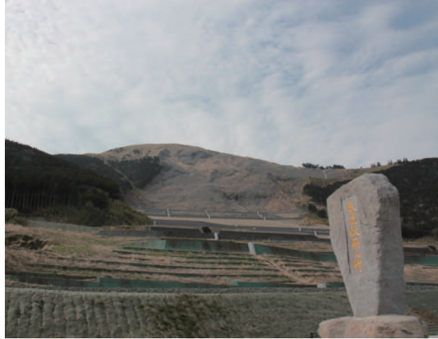
▲2016年熊本地震で最大級の斜面崩壊となった数鹿流崩れ
