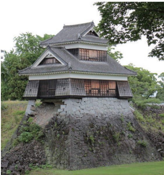
▲復旧にはなるべく元の材料を使う必要があるため、石垣の石も一つずつ番号をつけて管理しながらの復旧工事となる。このためとても時間がかかる
