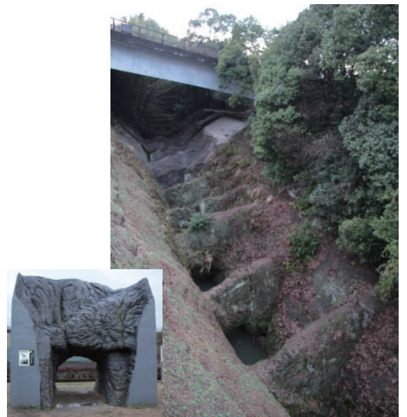
▲掘削時に一部を壁のように残し、その下辺をくりぬいてトンネル状にした「鼻ぐり」は、工事の簡略化と水流により川底に土砂がたまらないようにする仕組み
